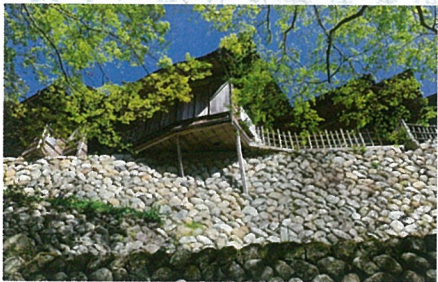
2本の柱で石垣に建つ【洗耳亭】
